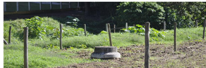
Poço de visita do interceptor para despoluição do Rio Capivari (Jundiaí) Foto: Josevane Victor
