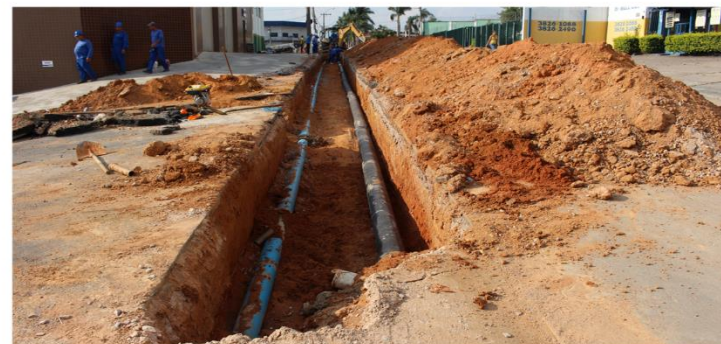
Substituição de rede de água (Vinhedo) - Foto: Josevane Victor
