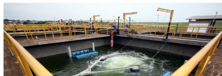
ETE San Martim (Campinas) - Foto: Manoel de Brito (Sanasa)
