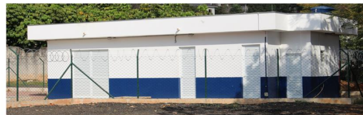
Estação Elevatória de Esgoto 3 no condomínio Marambaia (Vinhedo) Foto: Josevane Victor
